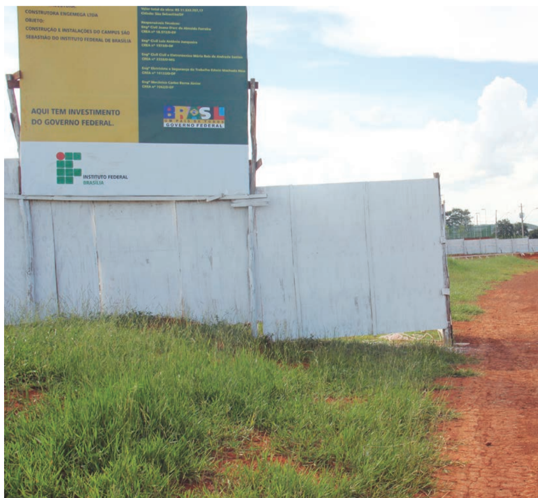
O prédio definitivo está sendo construído ao lado do provisório
