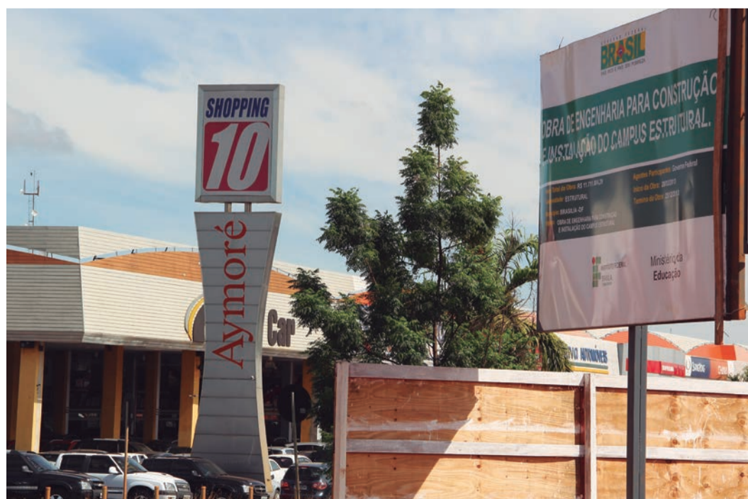
Prédio está sendo construído na entrada da Cidade do Automóvel
