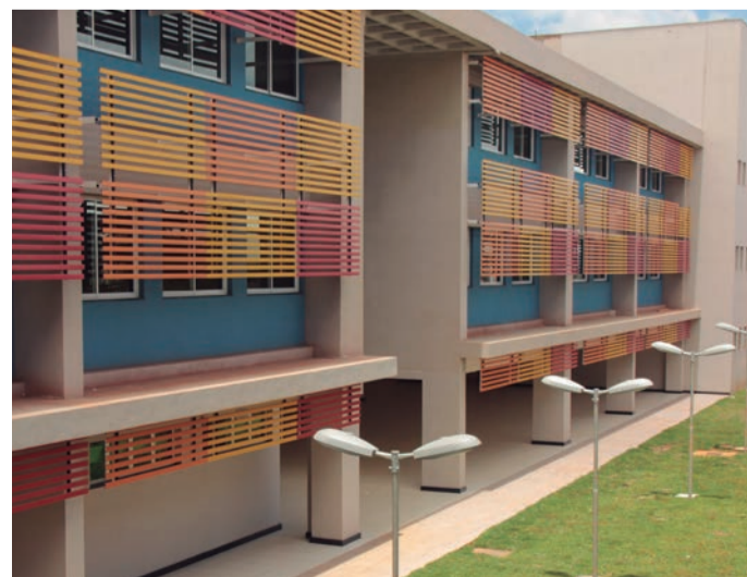
Blocos de salas de Aula do Campus Brasília
